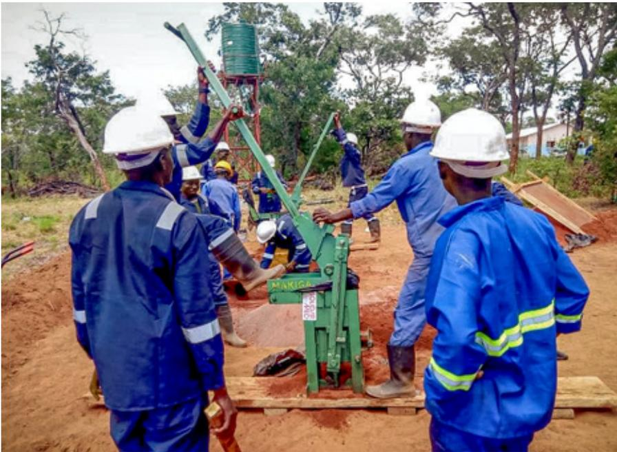
▲ Mithilfe der «Makiga»-Maschine formen Bauarbeiter hier die Erdzement-Blöcke. *Nzila Lubinda*
